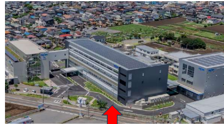
2024年6月に 狭山インテグレーションセンター完成
