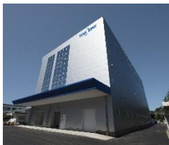
医療関連機器生産棟
